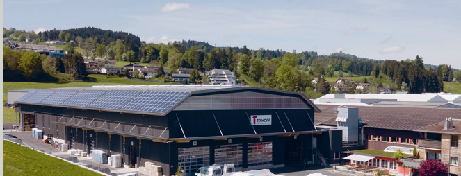
2800 Quadratmeter Platz bietet die neue Produktionshalle der Tschopp Holzbau AG in Hochdorf (LU).
